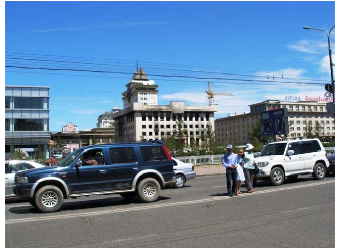
Ehemaliges Parteigebäude der MRVP. 29.06.09
